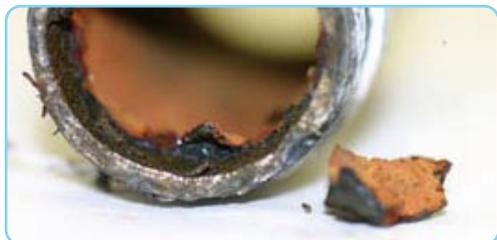
BW取付後、配管の管壁に黒錆が出来てきている状態。
