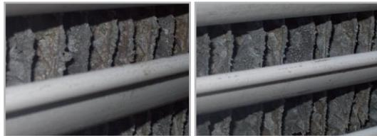
No.2 冷却塔(BWパンチボックス浸漬:スケールが剥離している)
